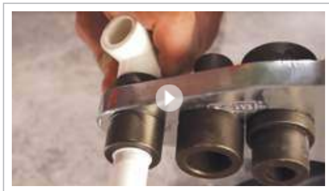
Монтаж полипропиленовых труб.
